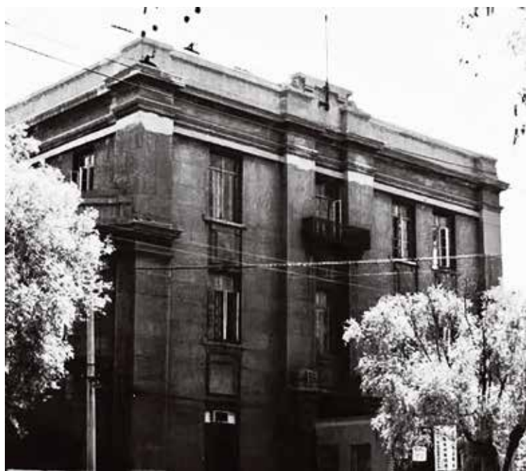
1953年3月，中央重工业部建筑材料工业管理局设计公司在沈阳正式成立，简称建工局设计公司。
