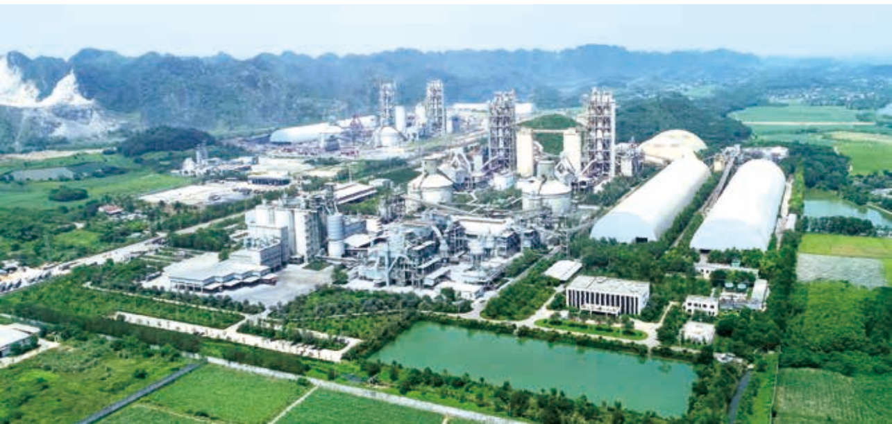
中材国际(南京)越南龙山四期6000t/d熟料水泥生产线及配套项目
