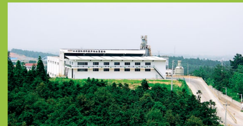
▲ 溧阳中材环保有限公司协同处置 450t/d 生活垃圾项目全景
