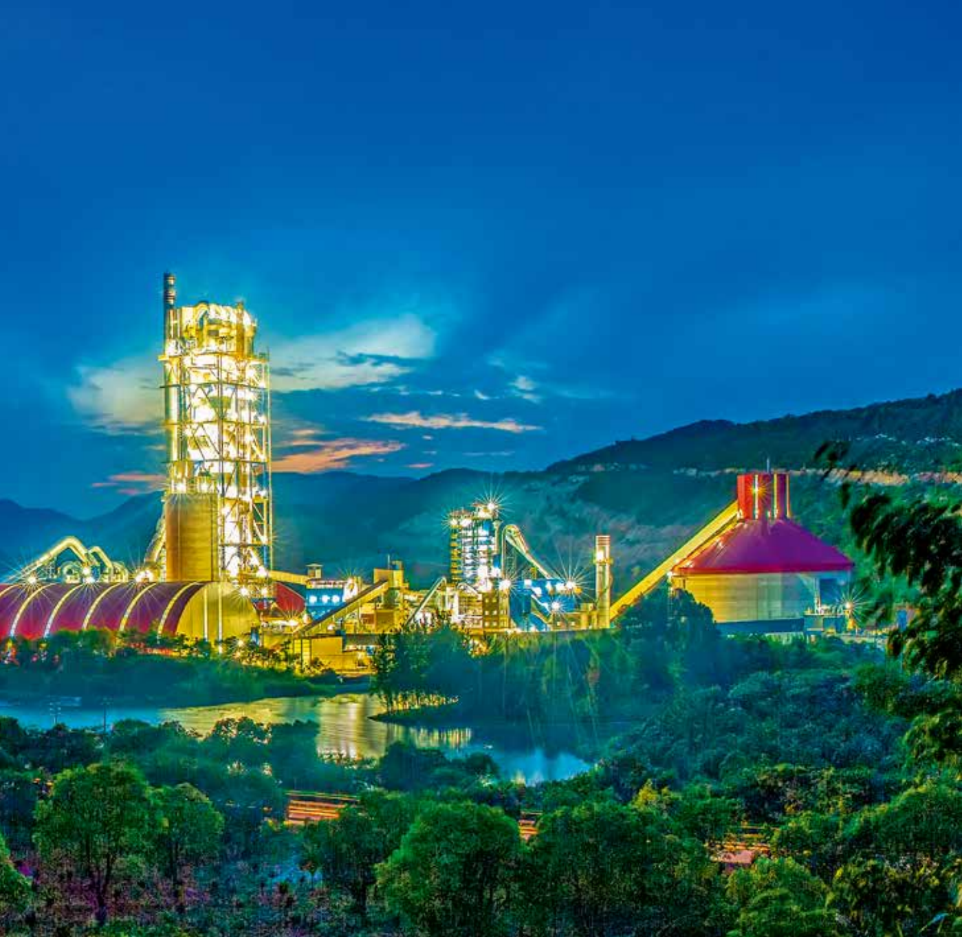
槐坎南方日产7500吨绿色化、数字化、智能化生产线
