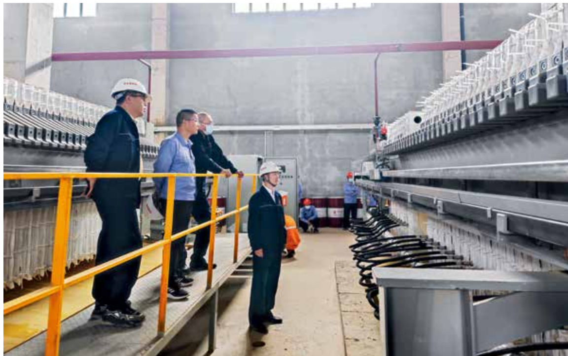
分离站-第二压滤车间小循环联调联试成功情景
