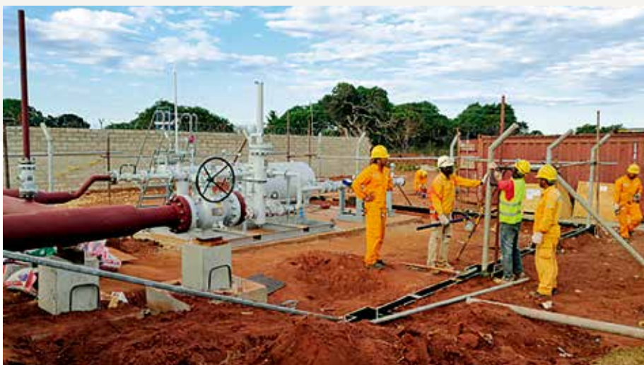
天然气入户项目施工现场
