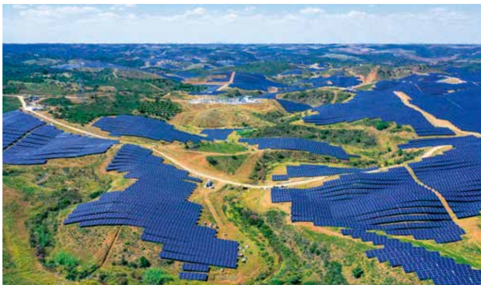
欧洲单体装机容量最大的光伏电站
