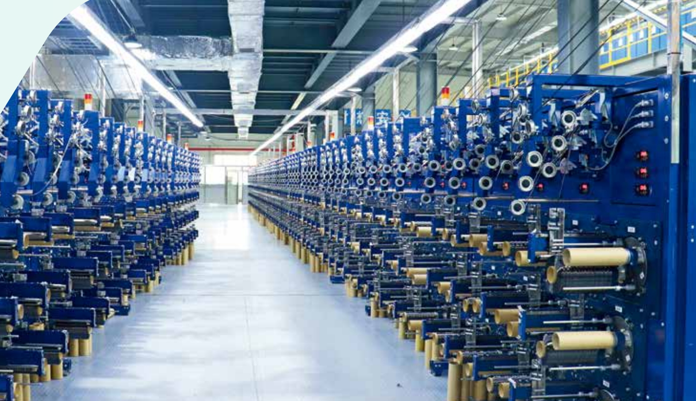
中复神鹰西宁万吨碳纤维基地碳化车间
