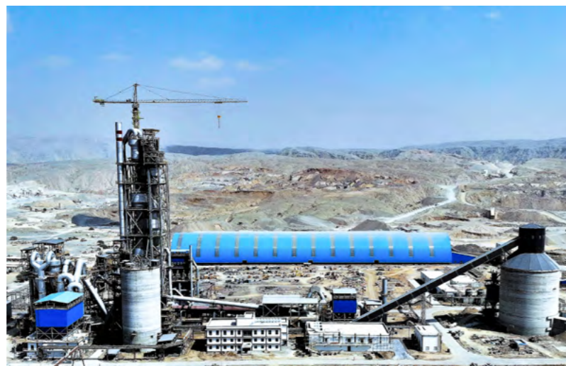
◎ 天津水泥院阿联酋JSW项目
