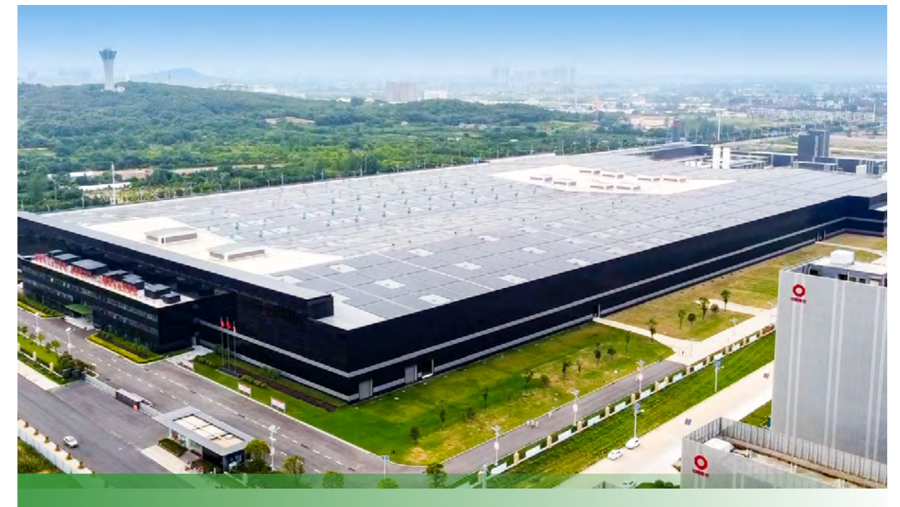
◎ 凯盛科技单体规模 10 兆瓦 薄膜光伏建筑一体化（BIPV）应用示范项目
