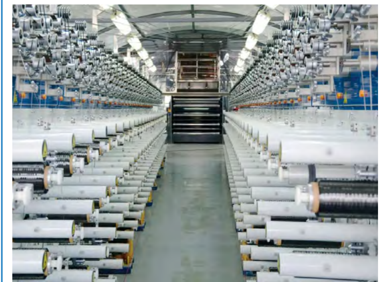
◎ 中复神鹰 T1000 级碳纤维生产线
