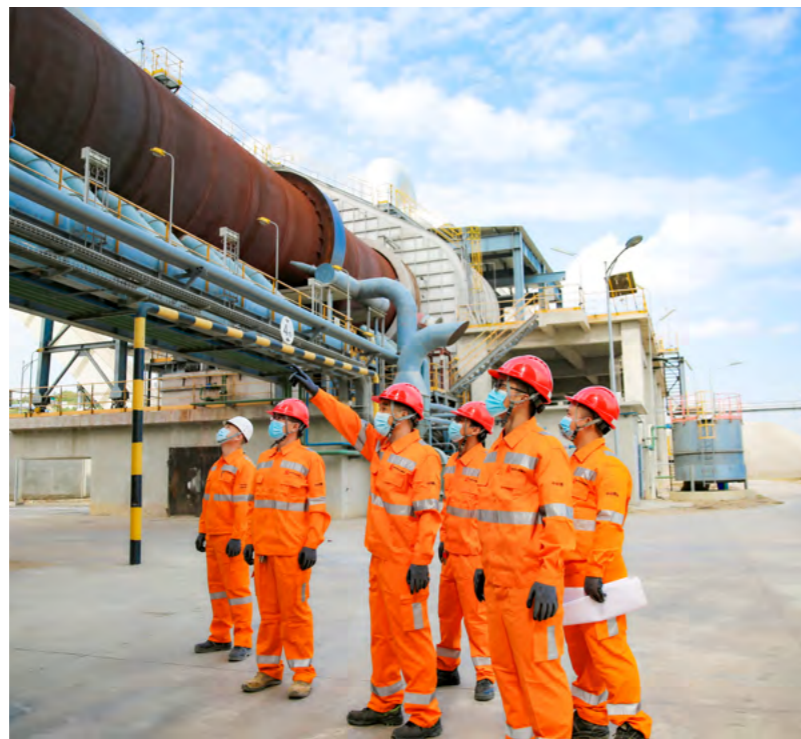
中材建设尼日利亚 EDO 项目部进行安全和工艺生产联合检查
