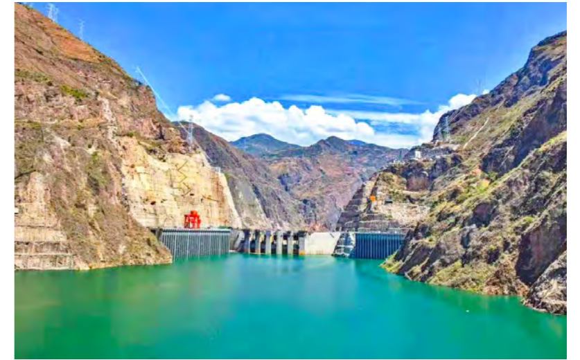
◎ 中国建材总院低热水泥助力建设世界最薄乌东德水电站大坝
