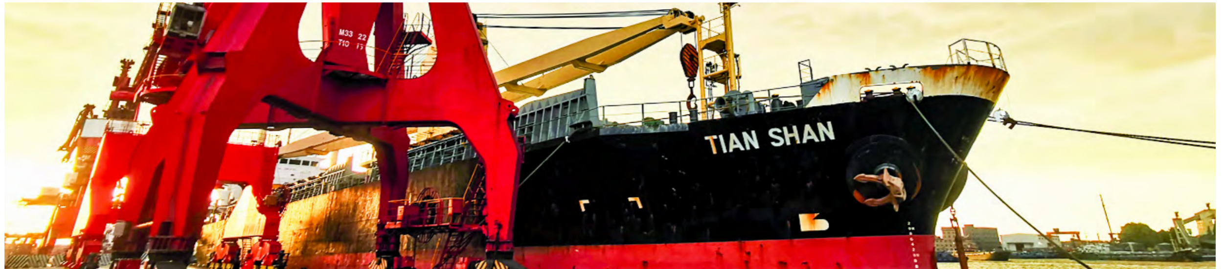
中材国际（南京）印尼BAYAH2项目10000吨/天生产线B06批次大件装船
