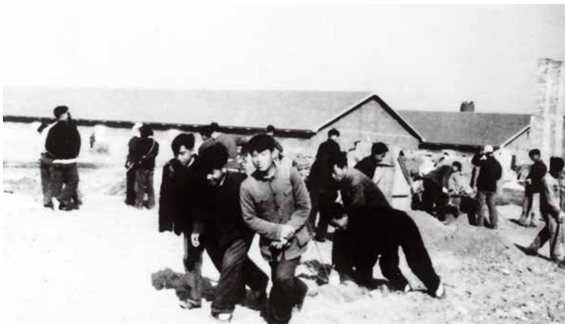
1956年，洛阳玻璃厂开始兴建时的火热劳动场面
