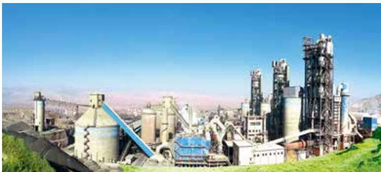
永登祁连山水泥有限公司全景
