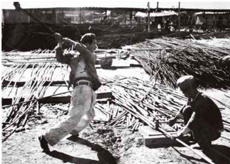
傅德成（左）热火朝天地参与永登水泥厂的建设
