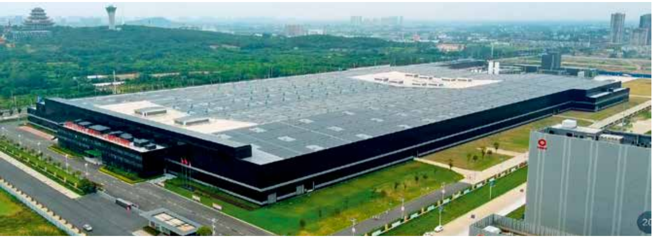
8.5代TFT-LCD超薄浮法玻璃基板生产线薄膜光伏建筑一体化应用示范项目
