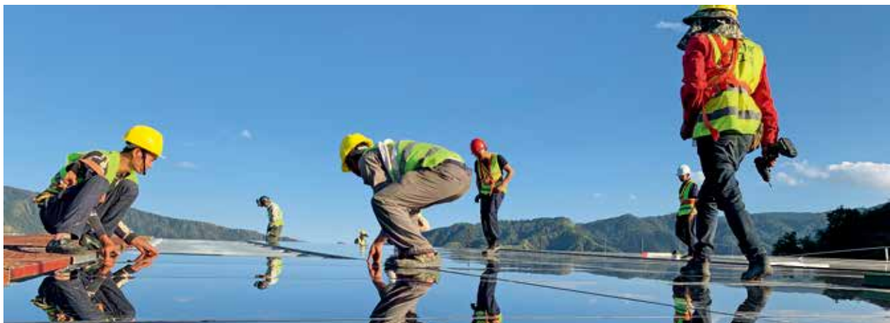
碲化镉发电玻璃应用项目施工场景
