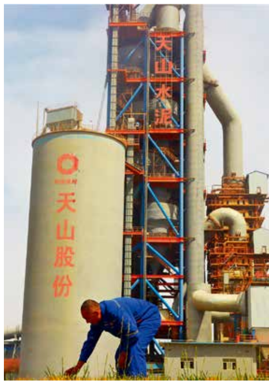
发现公司有损坏的地方，主动上前维修
