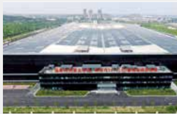
我国首条高世代浮法玻璃基板生产线&世界单体规模最大薄膜光伏建筑一体化应用示范项目
