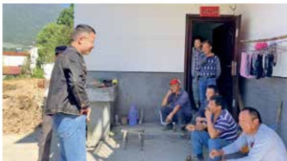
集团援建查村组道路施工现场：和刚下工休息的村民攀谈，了解施工进度
