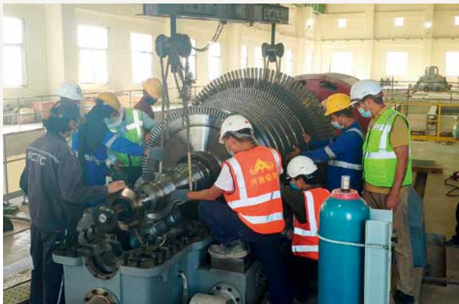
正在进行汽轮机的安装
