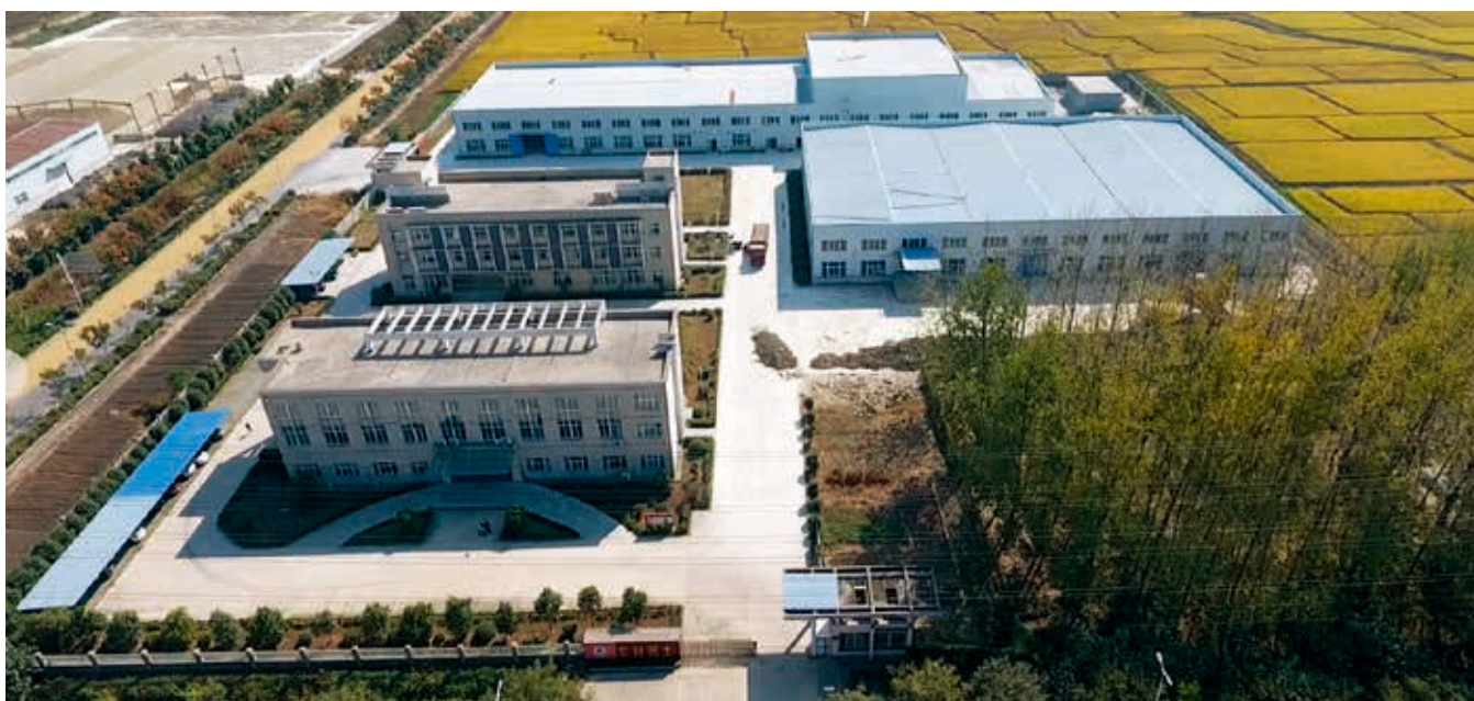
盱眙县中材凹凸棒石粘土有限公司厂区
