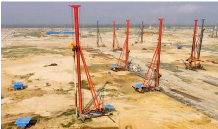
尼日利亚丹格特炼化厂水池基桩工程
