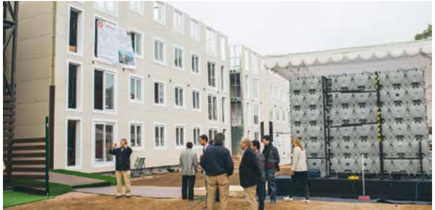
智利中建材绿色小镇一期工程
