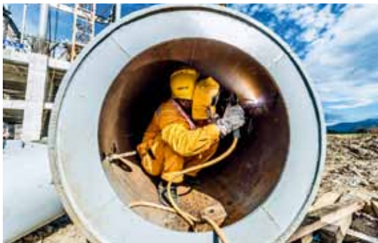
印尼北苏海螺一期项目
