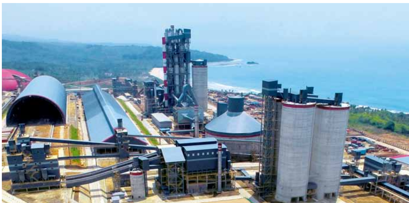
生产线结构紧凑, 布局合理
