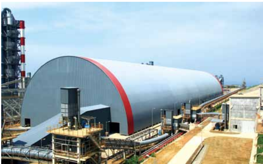
辅材原煤预均化堆场：钢结构跨度大，安装精准
