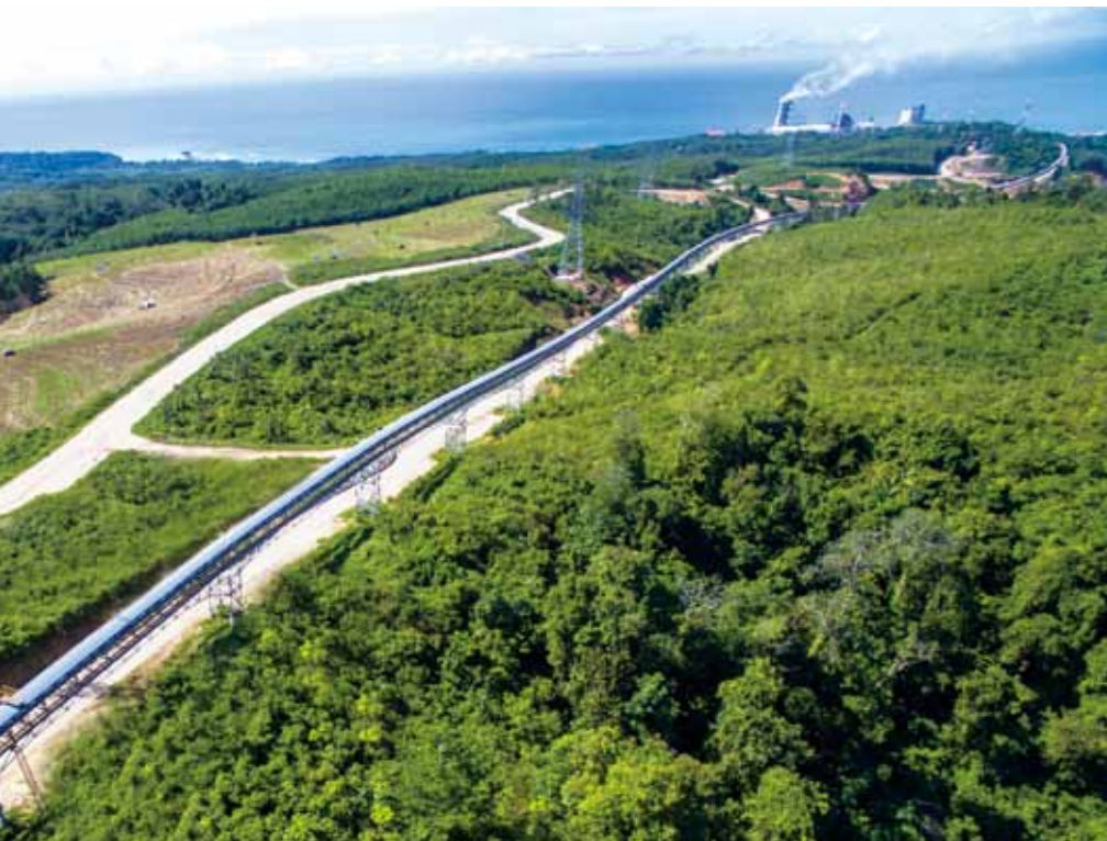
输送廊道：施工精良，气势恢宏
