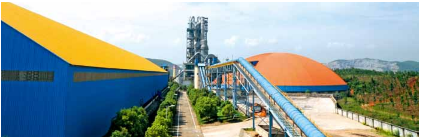
湖州白岷南方厂区
