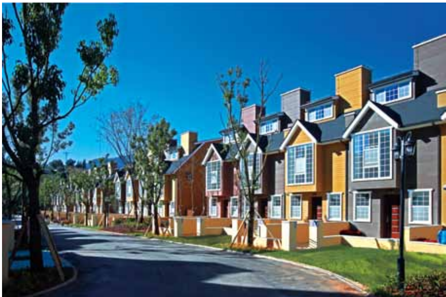
客户根据需求个性化定制新型房屋
