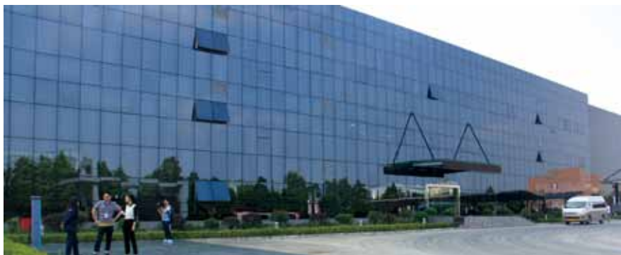
成都中建材公司外墙和地面都铺上了碲化镉发电玻璃
