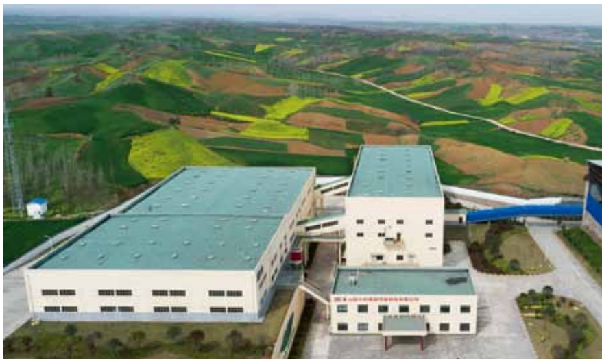
山西中材桃园协同处置危废5万吨项目
