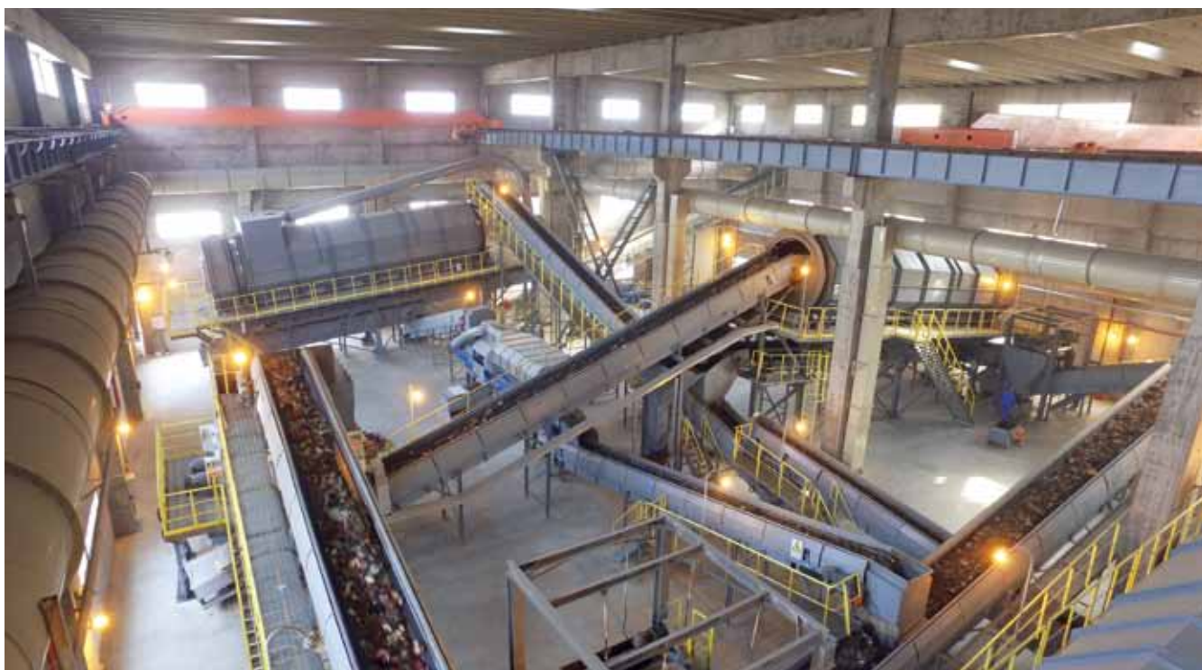
建设的老河口项目示范工艺线
