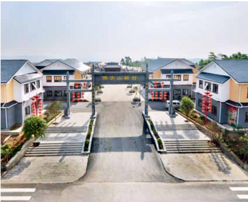
四川广安新农村建设项目
