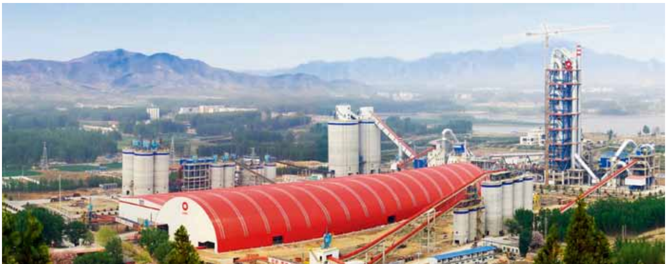
泰安中联智能化水泥工厂
