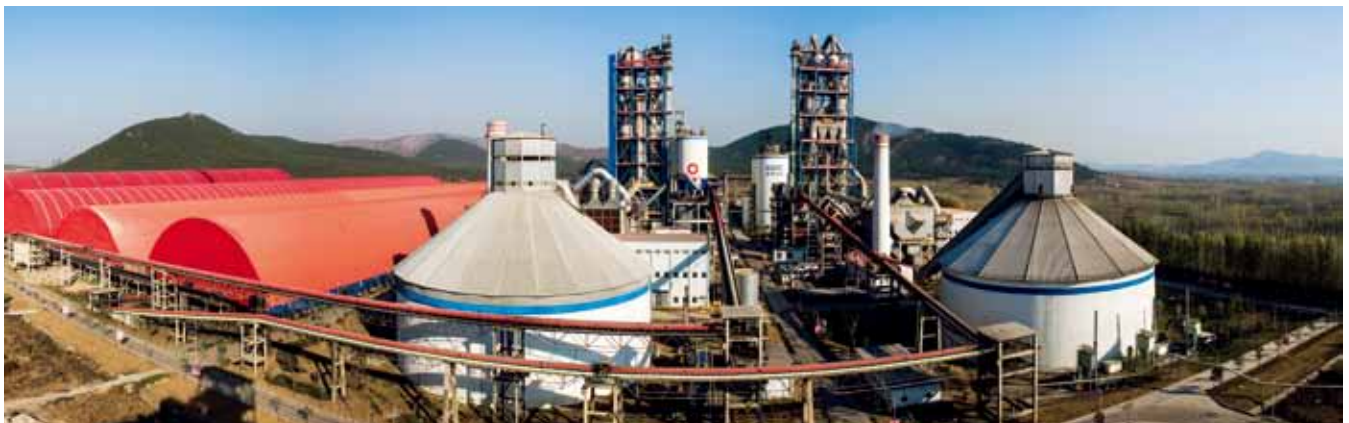
双万吨水泥生产线
