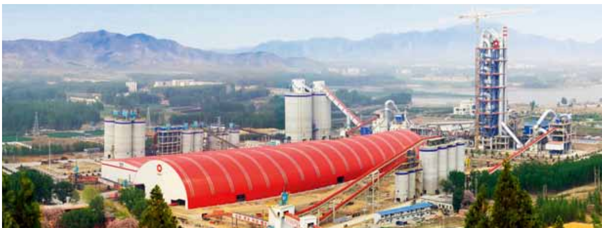
工业4.0智能化水泥生产线
