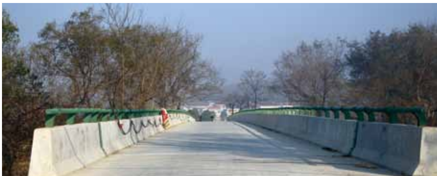
集团定点帮扶石台县援建的重点项目——中国建材科技桥建成通车
