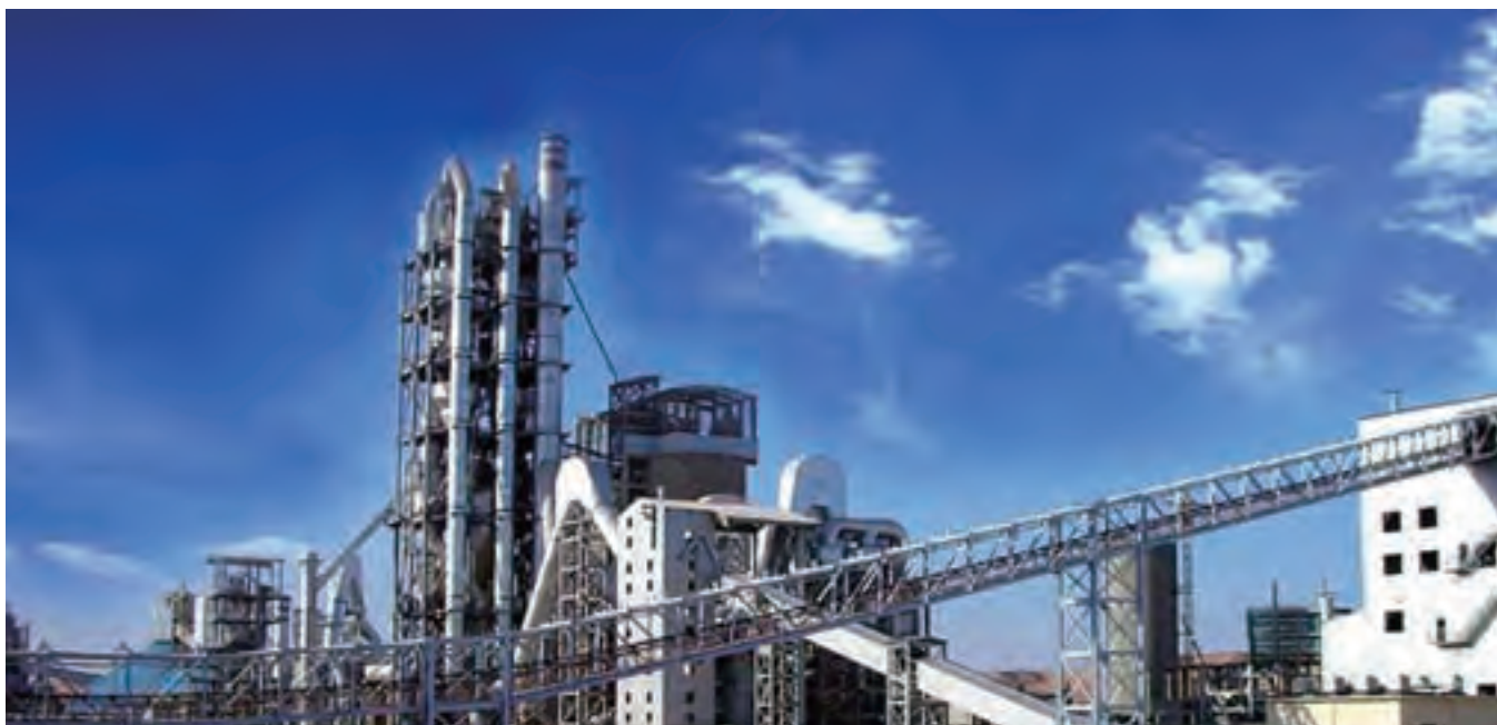
合肥院承建的沙特纳吉兰6000t/d水泥熟料生产线
