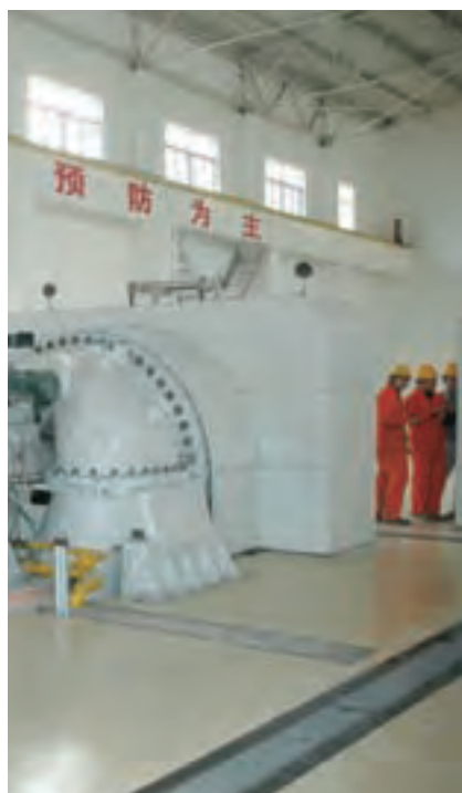
纯低温余热发电机组
