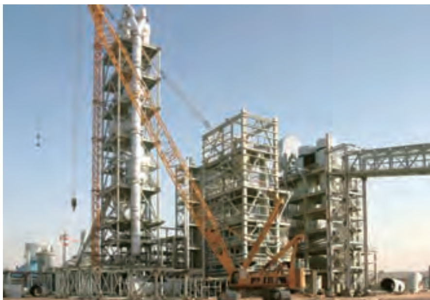
海外水泥项目建设工地
