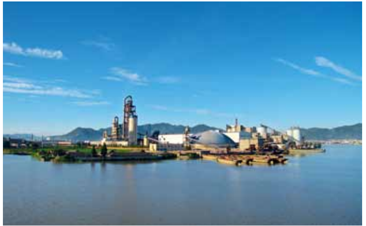
绍兴污泥处理生产线被誉为“水乡明珠”
