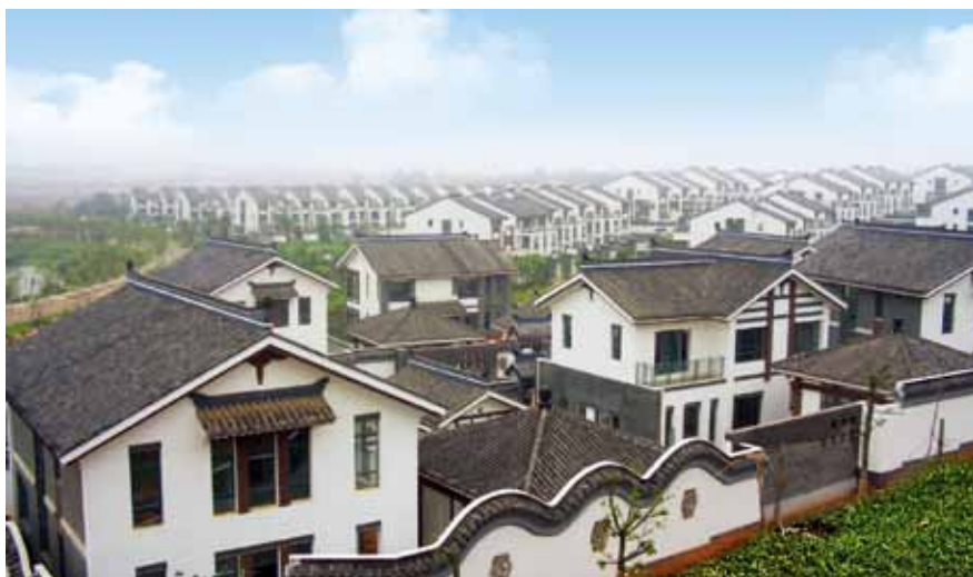
在武汉宝安建设的新型房屋项目
