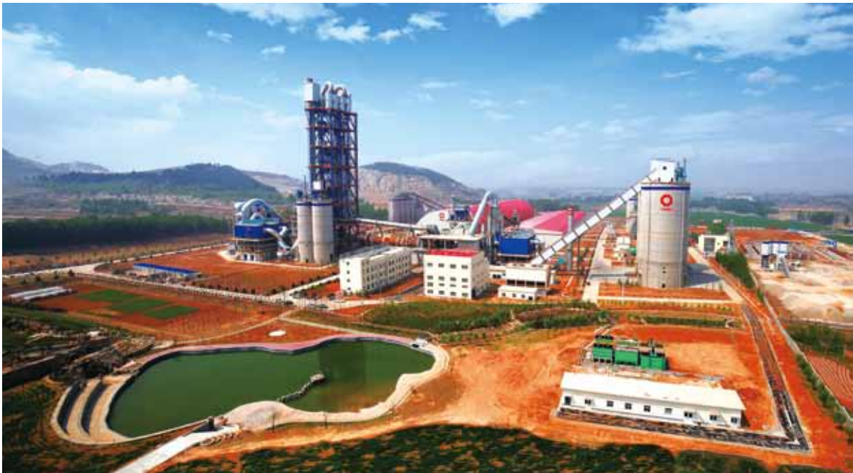
工业4.0智能化水泥生产线
