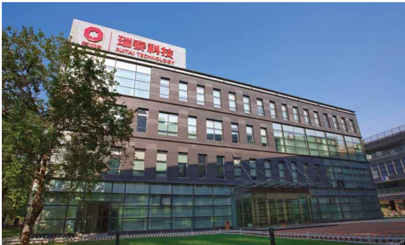
瑞泰科技新办公楼
