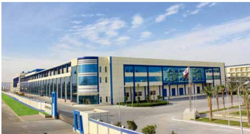
在埃及投资建设的玻纤生产基地
