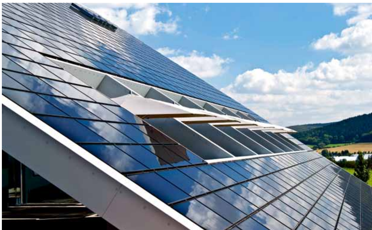
铜锣钵晒太阳能光伏项目
