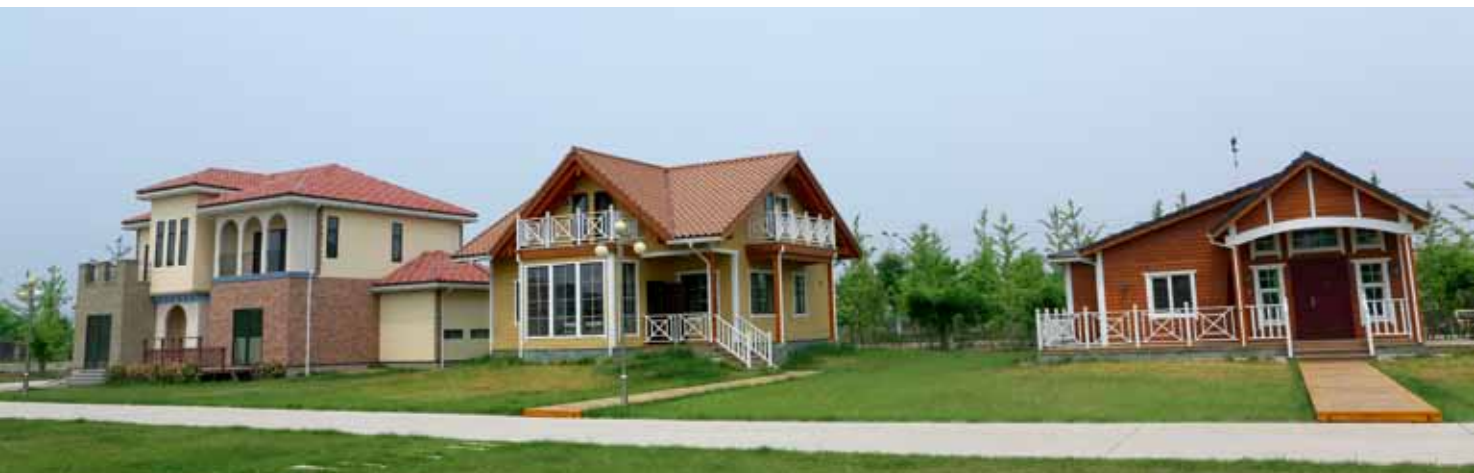
在北京密云建设的新型房屋基地
