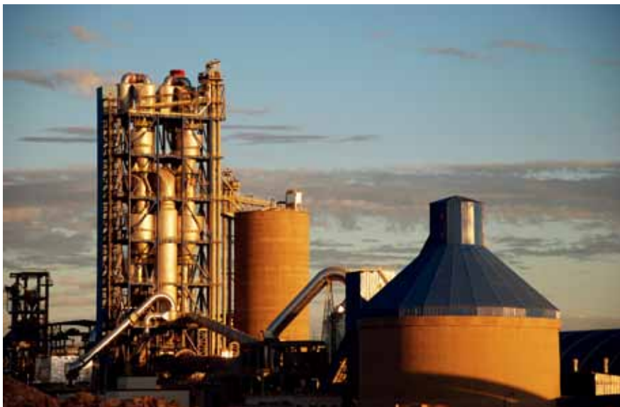
沙特AL-Jouf日产5000吨熟料水泥生产线工程
