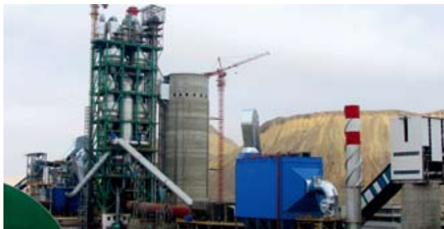
中国建材承建的阿塞拜疆新型干法水泥项目
