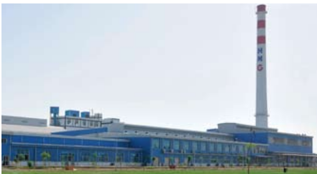
中国建材承建的印度HNG600吨浮法玻璃生产线
