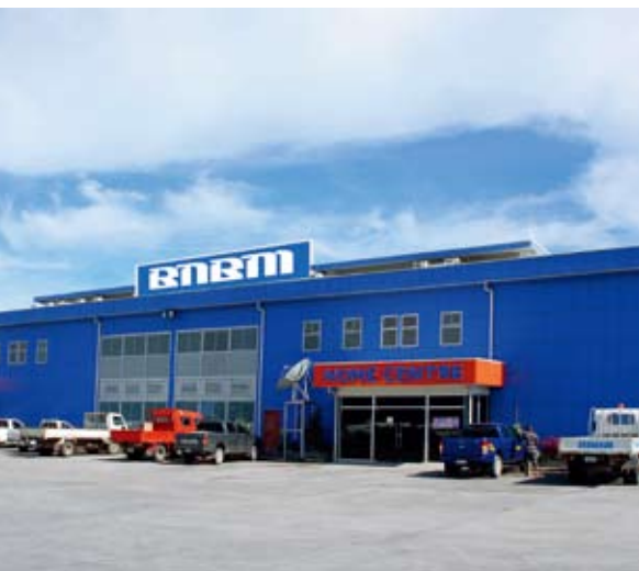
中国建材在巴布亚新几内亚运营的BNBMHOME 建材家居一体店
