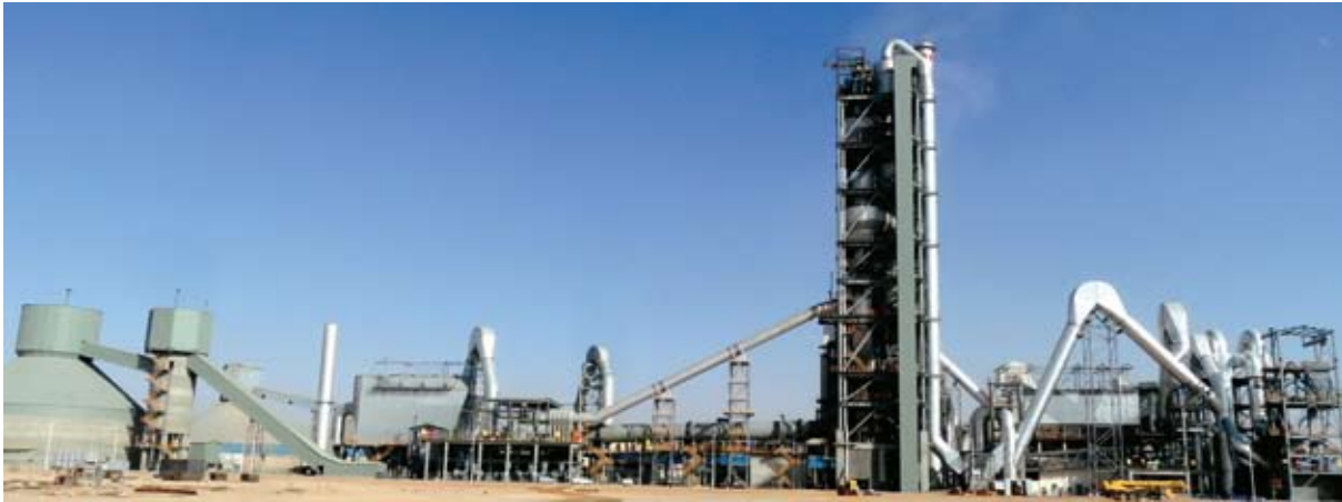
NRCC二线 工程全景
