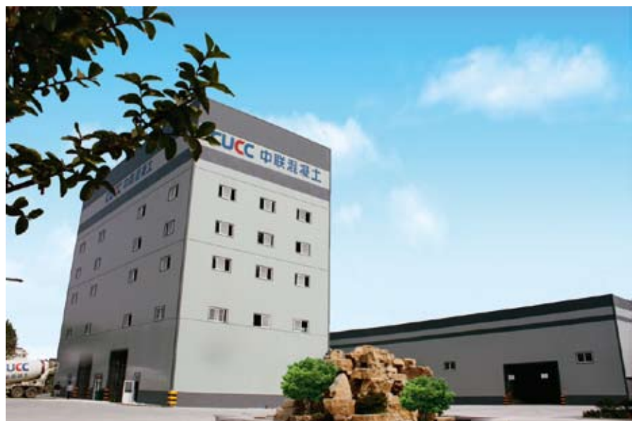
青岛中联混凝土搅拌站外景
