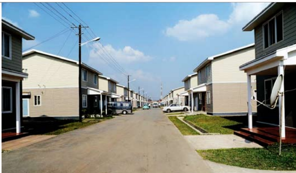
赞比亚项目Makeni地块实景图
