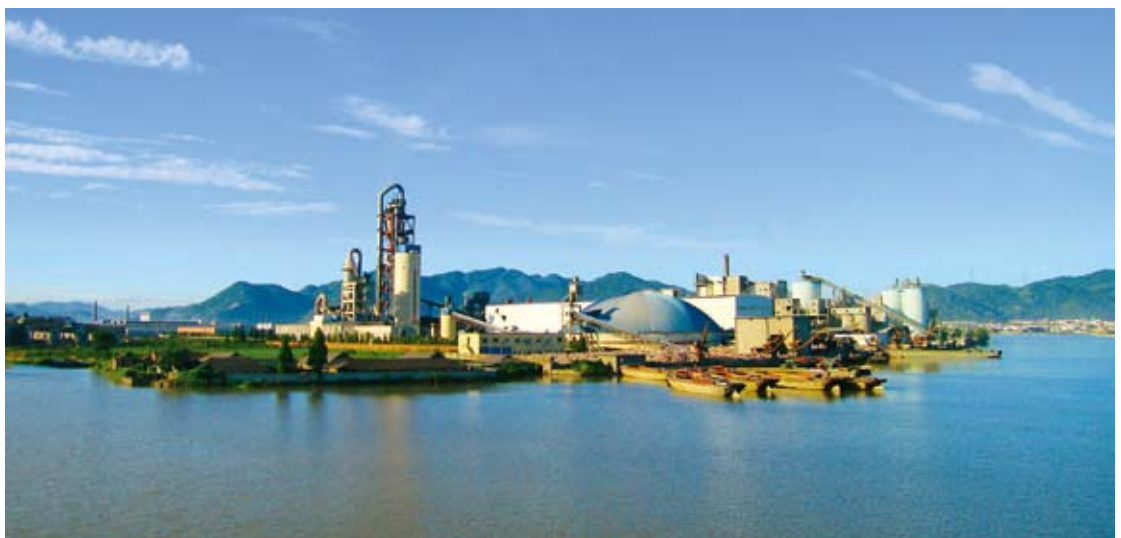
中国建材集团水泥企业污泥处理生产线
