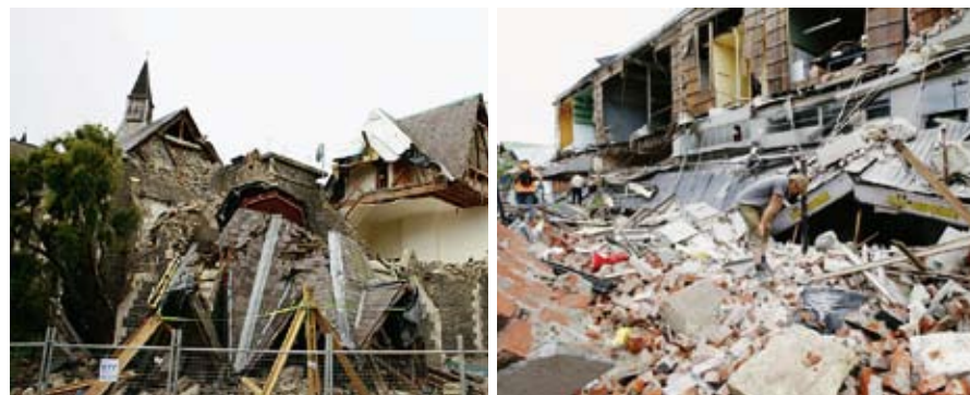
图3. 新西兰地震房屋破坏情况：轻质结构房屋未发生整体坍塌，很少造成人员因掩埋而死亡
