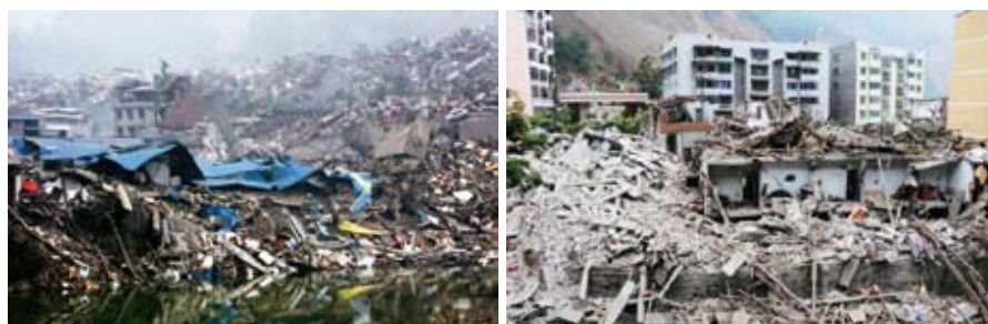
图1. 2008年汶川地震房屋破坏情况（此次地震8.0级共造成7万人死亡，1.8万人失踪，其中发生地震烈度9度以上的地区破坏极其严重）
